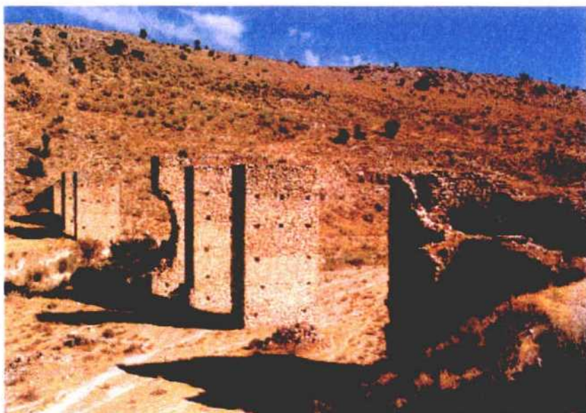
Obras interrumpidas de un acueducto del Canal de Carlos III
