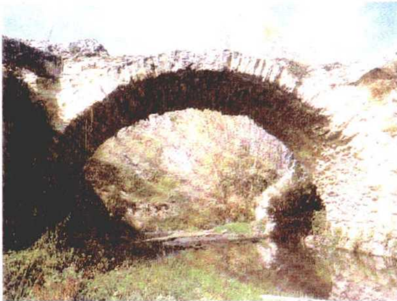
Puente de un solo arco, de época altoimperial
