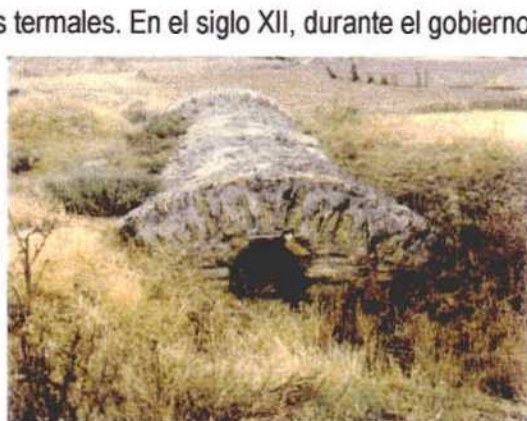
Algibe árabe de abastecimiento a la Malahá
