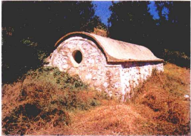
Construcción antigua de protección de uno de los regueros en donde nace el agua de Siete Fuentes
